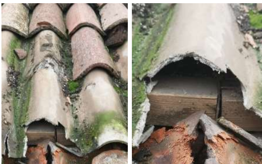
Sottomanto a onduline in fibre di cemento amianto
